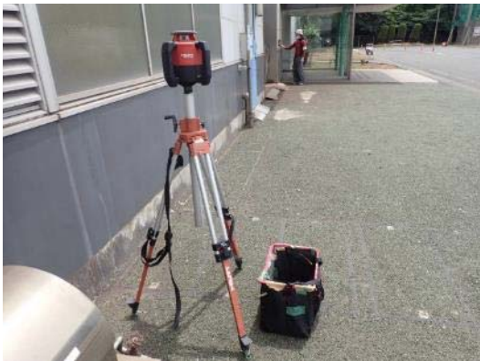
[写真 D]不同沈下調査状況
