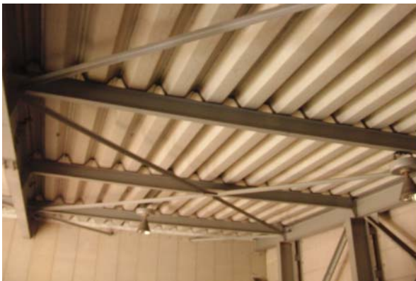
[写真 A]ブレース×の現地状況
