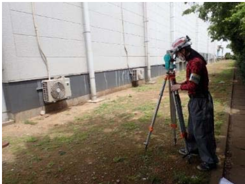
[写真 C]傾斜調査状況
