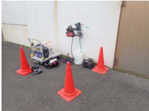
[写真 C] コンクリートコア抜き状況
