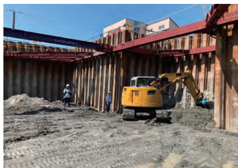
令和5年5月 地盤掘削・山留工事
