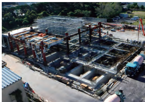
令和5年11月 鉄骨建方工事
