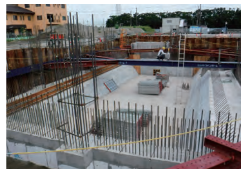
令和5年6月 ピット地下部
