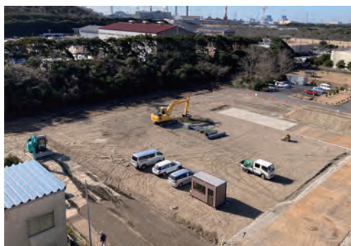
令和5年2月 工事着手
