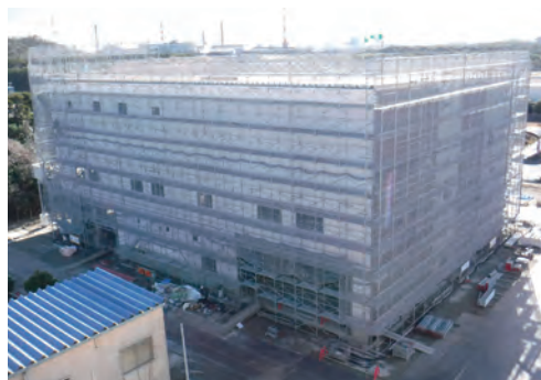
令和6年2月 外壁設置工事
