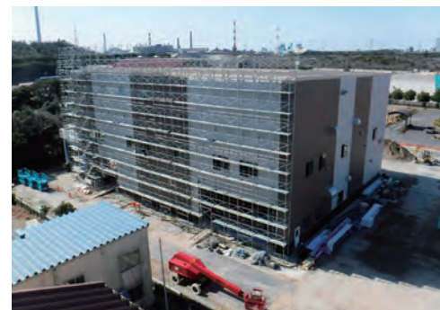
令和6年2月 外壁塗装工事
