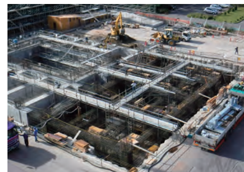
令和5年10月 基礎構築工事
