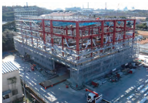
令和6年1月 鉄骨建方工事
