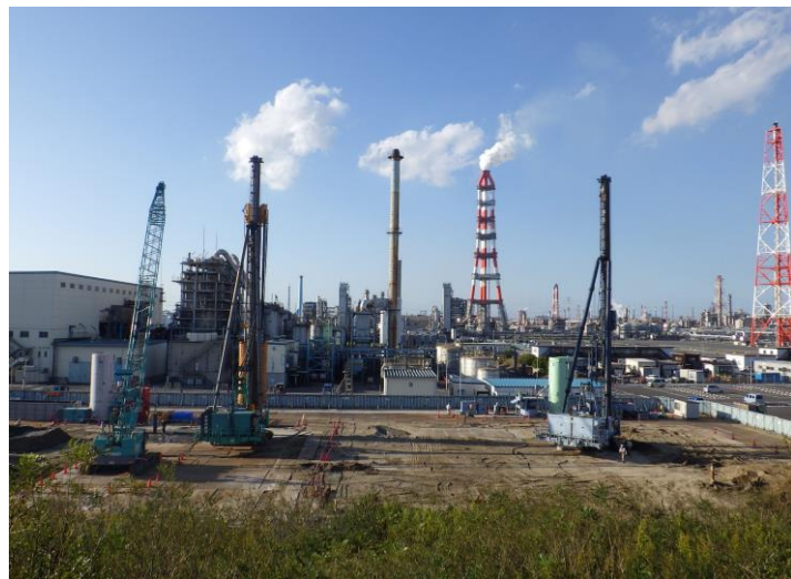
撮影日: 令和3年10月2日 撮影場所: 砂山都市緑地
