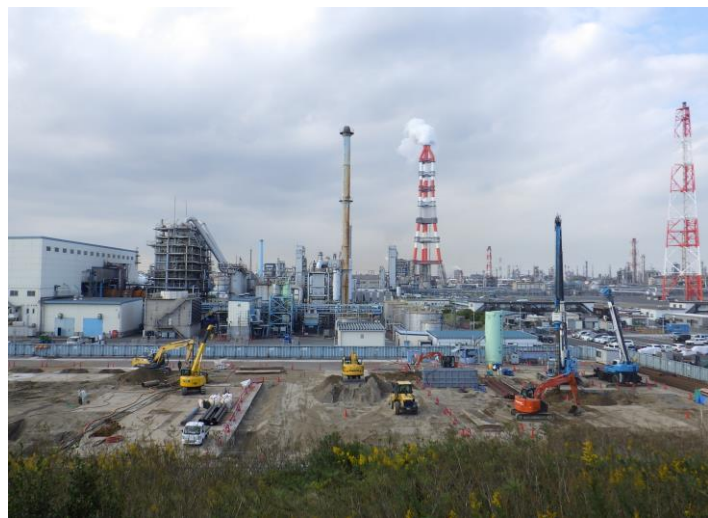
撮影日: 令和3年10月15日 撮影場所: 砂山都市緑地
