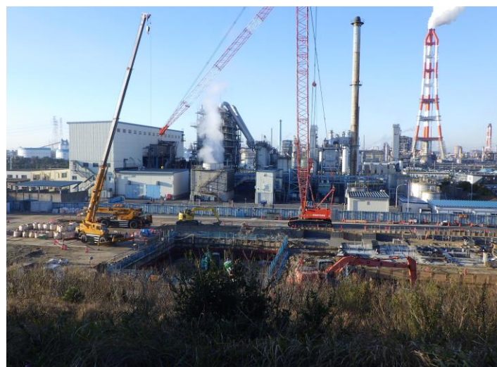
撮影日: 令和3年12月15日 撮影場所: 砂山都市緑地
