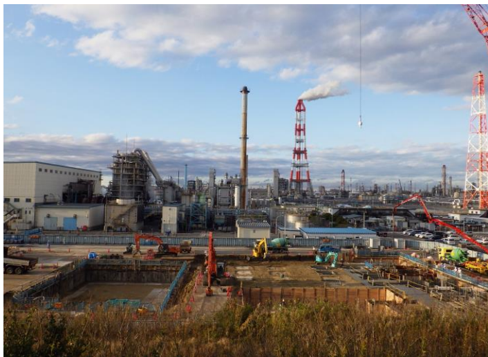
撮影日: 令和3年12月1日 撮影場所: 砂山都市緑地
